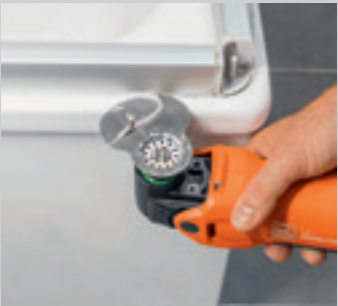
Elastiska mjukfogar går perfekt att ta bort före omfogningen.
